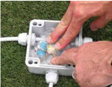
Ricoprire le connessioni, facendo attenzione a non lasciare zone di vuoto tra i contatti Cover entirely the connections, paying attention to not create empty spaces between the contacts
