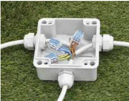
Cablare i cavi nella scatola di derivazione Wiring the cables in the derivation box
